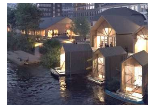
Trehusrekka, transformasjon og bygulv, A-Lab
