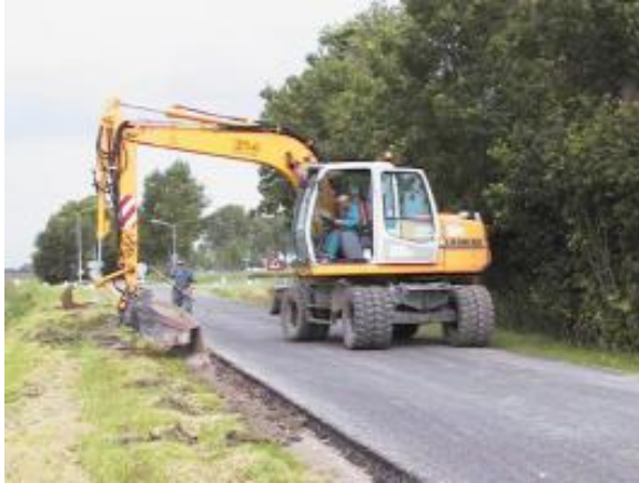
Foto 18. Bij het opnieuw op niveau brengen van een wegberm of de heraanleg ervan wordt best gewerkt met een voedselarme, streekeigen grondspecie. In ieder geval wordt nooit humus of meststoffen toegevoegd indien half-natuurlijke graslandvegetaties worden beoogd bv. glanshaverbegroeiing. Opbrengen van maaisel, afkomstig van een beoogde doelvegetatie uit de buurt kan de duurzame vestiging ervan versnellen.
