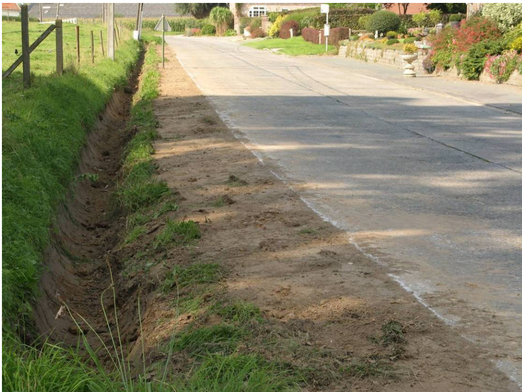
Foto 14. Afgeschaafde berm met geherprofileerde gracht te Denderwindeke-Vreckom. Wanneer het afschaven te diep gebeurt, verdwijnt ook de aanwezige zaadvoorraad. Het gewenste herstel van de vegetatie, in dit geval tot type 14, kan hierdoor lang op zich laten wachten, zeker wanneer betreffende plantensoorten ook in de omgeving ontbreken. Hier zijn gelukkig nog fragmenten van de begroeiing aanwezig en werd niet te diep gegraven. De volgende jaren zullen alleszins een aantal pioniersoorten opduiken (type 28 – 29). Indien de bodemzaadvoorraad toch verloren zou zijn, wordt in de hiertoe meest geschikte periode best maaisel opgebracht van goed ontwikkelde type 14 bermen uit de nabije omgeving. Op deze manier wordt gebruik gemaakt van de lokale soorten- en genenpoel voor de uitzaai van de gewenste soorten.
