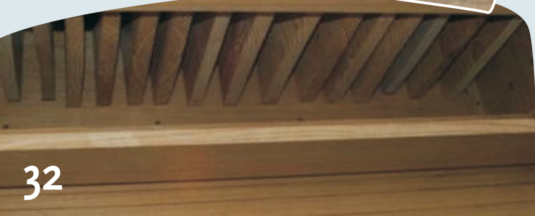
Tussenschotten in de microverblijfplaats zorgen voor het vasthouden van de warmte
